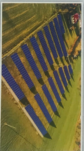
Obr. 4 – Fotovoltaická elektrárna v krajíně
